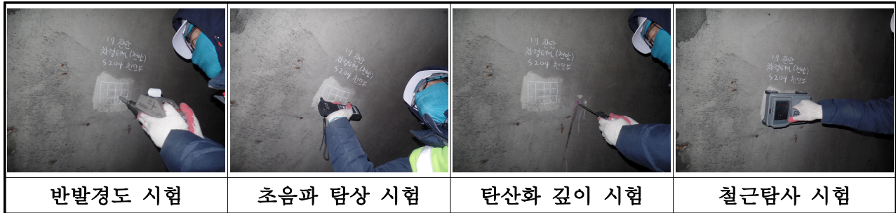
【사진 3.18】 콘크리트 내구성조사 전경
