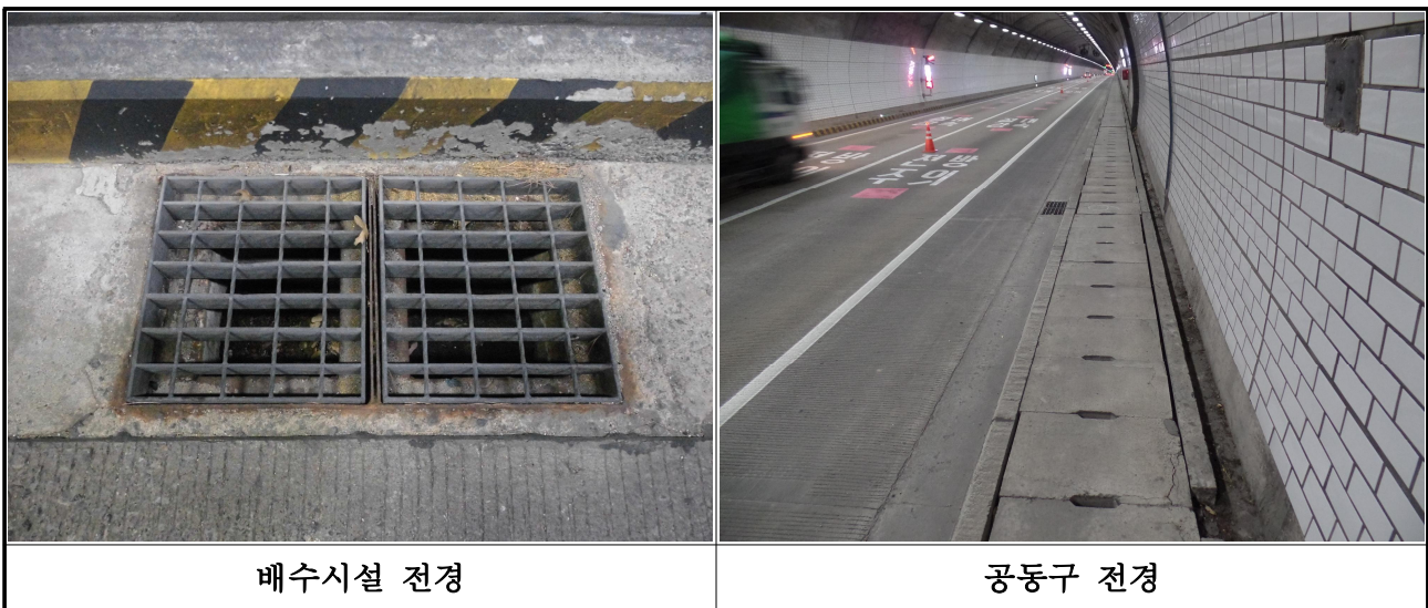
【사진 3.9】 배수시설 및 공동구 전경
