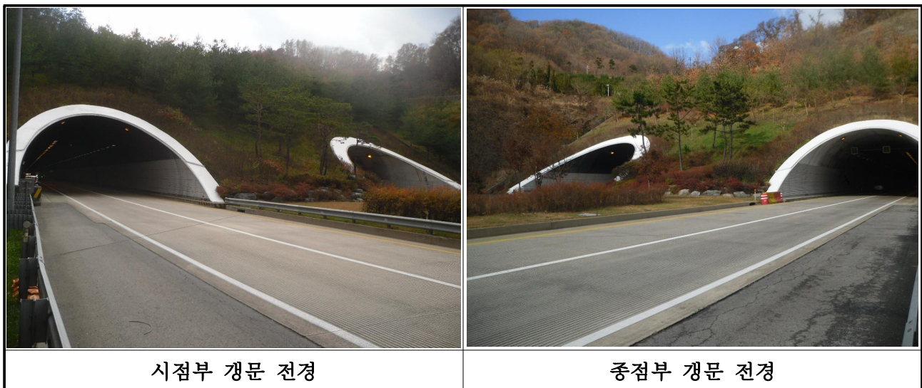
【사진 3.6】갭문 전경
