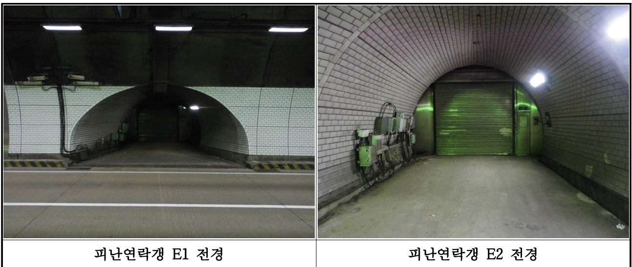
【사진 3.14】 피난연락갱 전경
