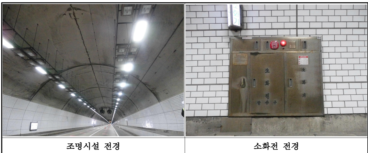
【사진 3.16】 부속시설 전경
